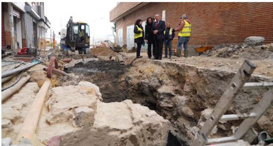
Visita a las obras de Ojo del Muelle.
