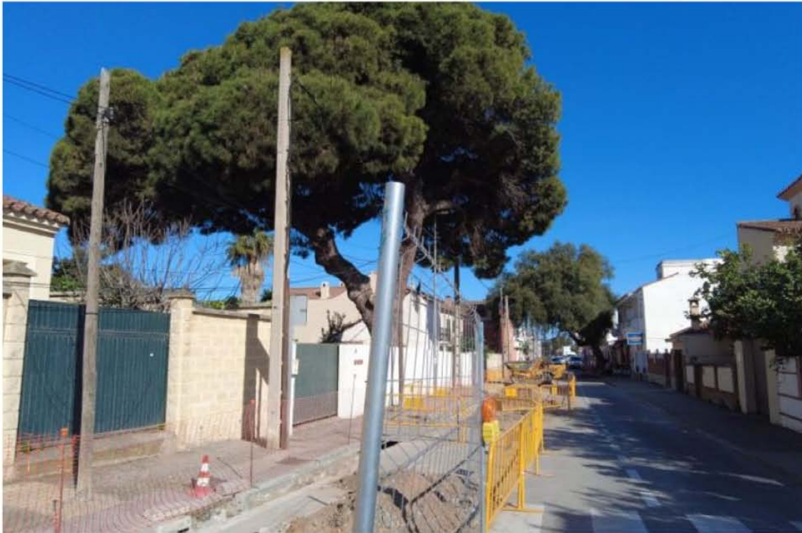
Obras en la zona del Embarcadero, en Algeciras
