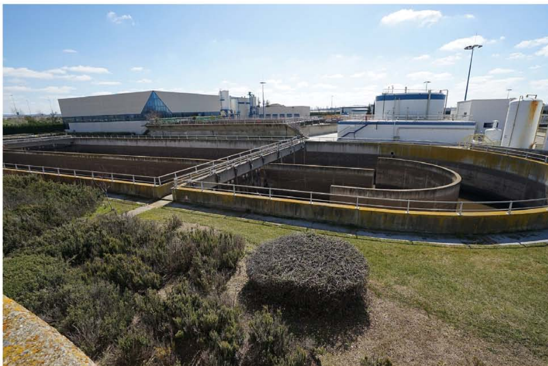
El Ayuntamiento de Valladolid impulsa la reparación de los digestores de la EDAR de Valladolid
