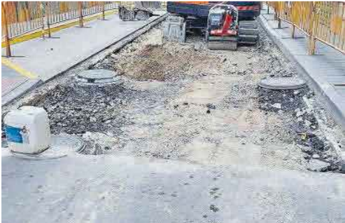
Obras en una de las calles afectadas.
