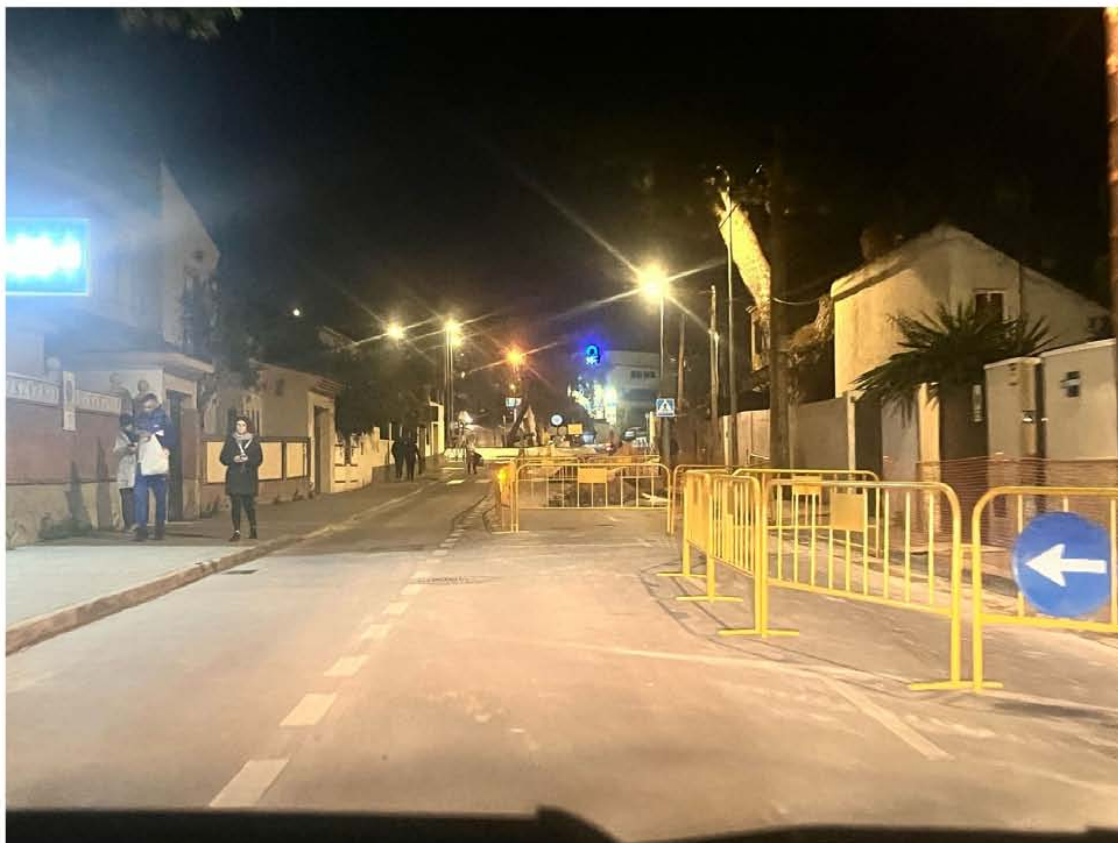
Emalgesa acomete obras de mejora en la red de abastecimiento en la avenida del Embarcadero.
