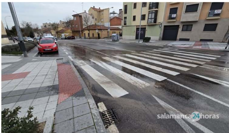
Rotura de una tubería en la calle Río Sil
